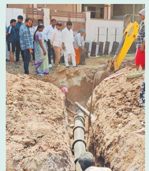
వెలుతురు, హయత్ నగర్, ఫిబ్రవరి 18: హయత్ నగర్ డివిజన్ సత్య నగర్ కాలనీలో మంగళ వారం నాడు స్థానిక డివిజన్ కార్పొరేటర్ కళైం సవజీవన్ రెడ్డి నూతన భూగర్భ డ్రైనేజీ పైప్ లైన్ పనులను ప్రారంభించారు. ఈ సందర్భంగా ఆయన మాట్లాడుతూ రాబోవు రోజుల్లో కాలనీవాసులకు ఎలాంటి భూగర్భ డ్రైనేజీ సమస్యలు తలెత్తకుండా పైప్ లైన్ నిర్మాణం చేయాలని, అదేవిధంగా
