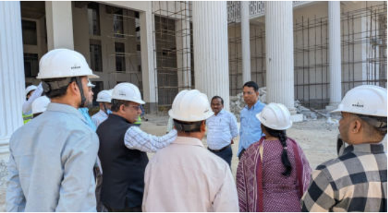
అల్వాల్ టీమ్మ హాస్పిటల్ నిర్మాణ పనులను పరిశీలించారు.
